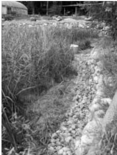
Die Mauer des tiefen Klärbeetes der zweiten Stufe mit Schilf
